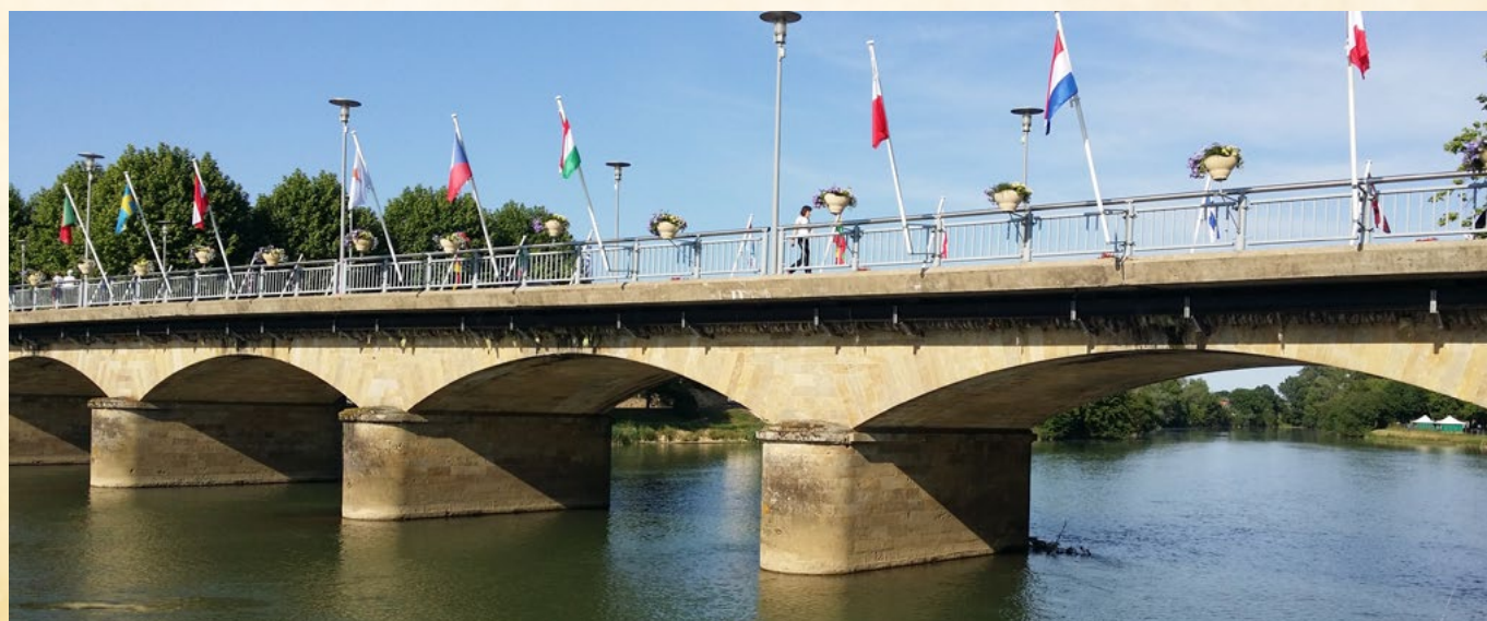
Le pont sur l'Adour
